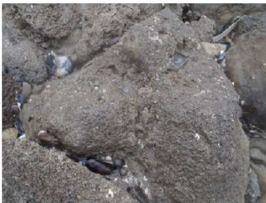
Figure 44 : Quelques moules subsistent entre de petits blocs minés par les Polystyros (au niveau de 75).
